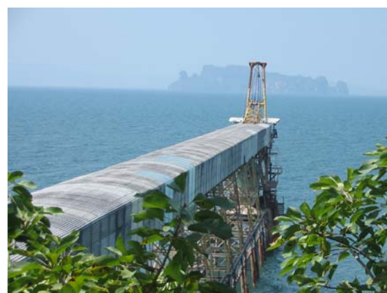
สายพานลำเลียงเพื่อขนถ่ายยิปซัม
