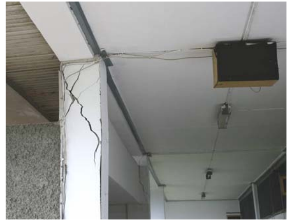
รูปที่ 1.2 ความเสียหายของโรงเรียนใน อ.เมือง จ.เชียงราย เนื่องจากแผ่นดินไหวขนาด 6.3 ในวันที่ 16 พฤษภาคม 2550 บริเวณพรมแดนไทย ลาว
