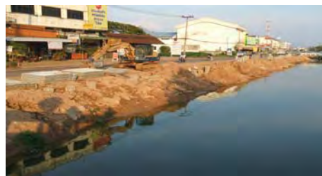
ข. ขุดลอกคลอง เพื่อปรับปรุงเป็นสถานที่พักผ่อนแก่ชุมชน ทำให้แหล่งน้ำดีขึ้น
