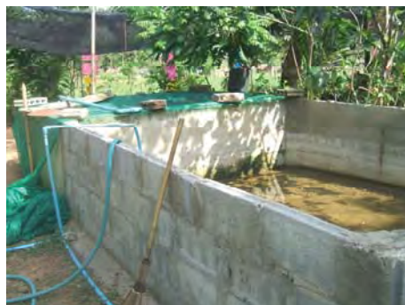
ภาพที่ 2 บ่อพักน้ำบาดาล
