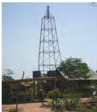
ภาพที่ 18 โครงสร้างกังหันลม สูบน้ำจากบ่อบาดาลในโครงการ “เขี้ยวธรรมชาติ”
