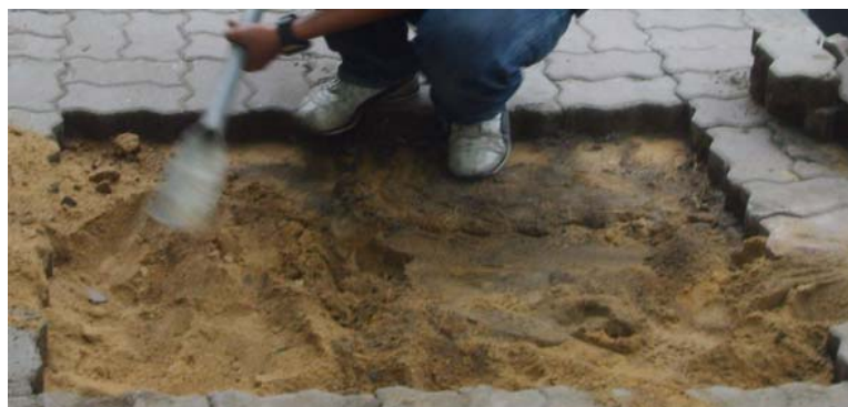
ภาพที่ 4-10 การเตรียมพื้นที่ก่อนการปูพื้นด้วย บล็อกประสานปูพื้นผสมตะกอนดินจากน้ำประปา
