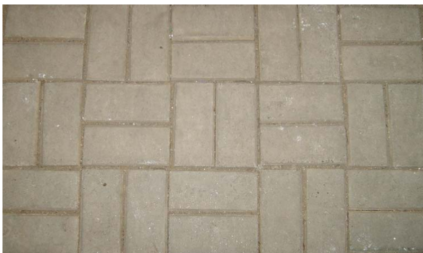
ภาพที่ 4-11 พื้นทางเท้าที่ปูด้วย บล็อกประสานปูพื้นผสมตะกอนดินจากน้ำประปา
