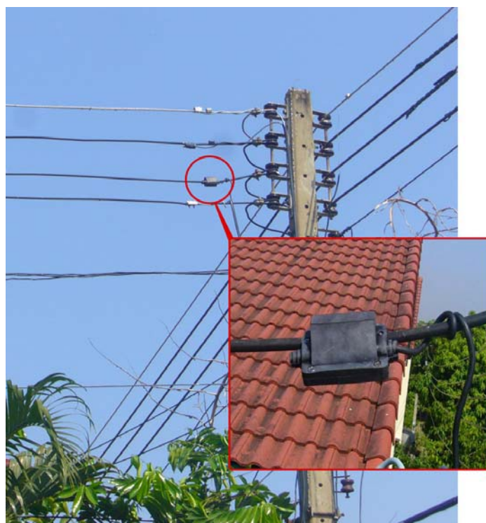
รูปที่ 24 การติดตั้งใช้งานนวนหุ้มข้อรัดสายไฟฟ้าแบบพีจีในระบบจำหน่ายของ กฟภ.
