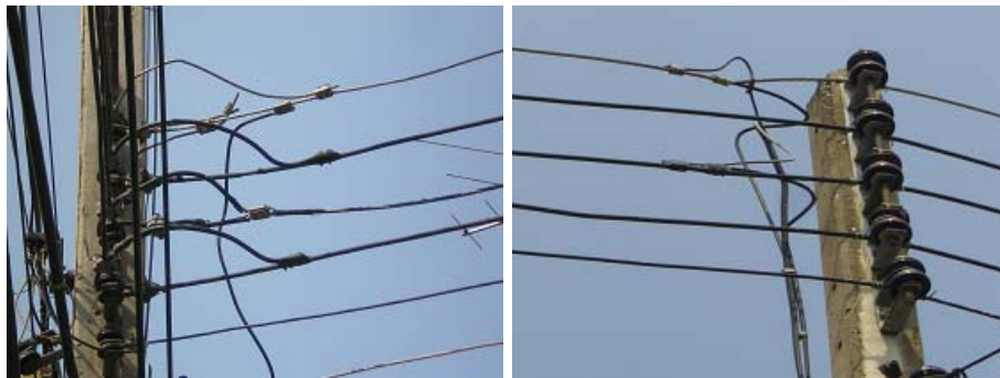
รูปที่ 1 การต่อสายไฟฟ้าด้วยข้อรัดสายไฟฟ้าแบบพีจีในระบบจำหน่าย
