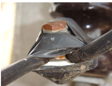
รูปที่ 8 ข้อรัดสายไฟฟ้าแบบพีจีที่ผ่านการใช้งาน
