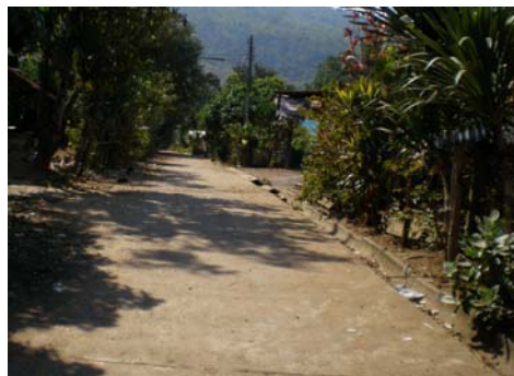
ถนนคอนกรีตกลางหมู่บ้าน
