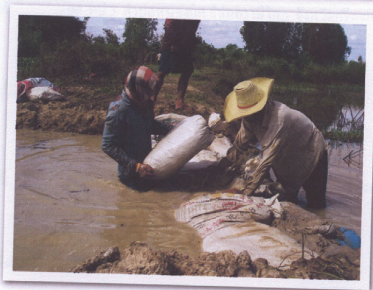
การทำคันดินกันน้ำเพื่อกักเก็บน้ำฤดูแล้งและสร้างแหล่งเพาะพันธุ์ปลา ในพื้นที่ที่ท่วมทุกปี
