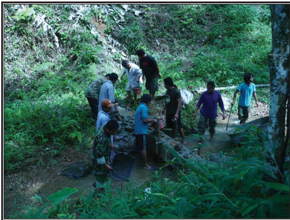
ซ่อมฝายกันกั้นน้ำ
