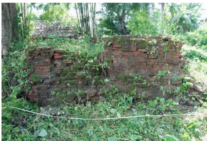
รูปที่ ข.520 ผนังอิฐด้านทิศตะวันตกเฉียงเหนือ
