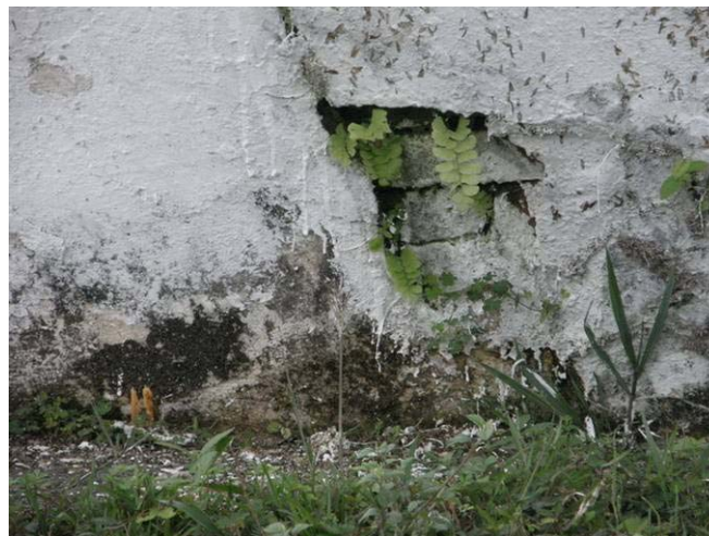
รูปที่ ข.459 การบูรณะส่วนฐานด้วยการเสริมอิฐ
