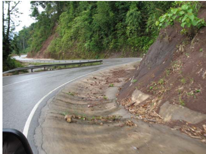
ร่องน้ำคอนกรีตเพื่อเป็นทางน้ำไหล
