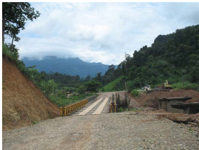
สะพานไม้บนเส้นทางหมายเลข 8 ที่อาจรับน้ำหนักได้ไม่เกิน 20 หรือ 23 ตัน ขณะนี้กำลังสร้างสะพานคอนกรีตใหม่อยู่ข้างสะพานอันเก่า แต่การสร้างสะพานแห่งนี้เป็นไปค่อนข้างช้า ถ่ายภาพโดย ชาญชัย ศรีพนา (25 สิงหาคม 2008)
