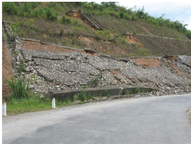
สภาพชำรุดของกำแพงกั้นดินบนเส้นทางหมายเลข 12 ในเวียดนาม
