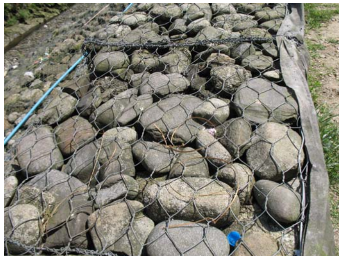
หินที่ก่อและถูกเชื่อมด้วยปูนซีเมนต์ มีตาข่ายโลหะคลุมอีกชั้นหนึ่ง ถ่ายภาพโดย ปรียานุช พวงนาค (21 พฤษภาคม 2008)
