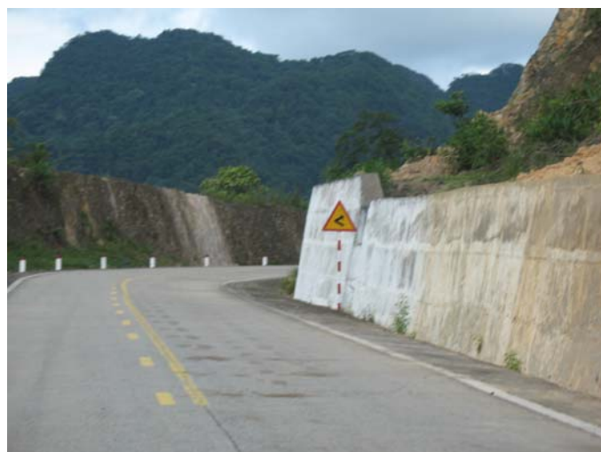
การฉาบคอนกรีตกันดินถล่มจากภูเขา ถ่ายภาพโดย ปรียานุช พวงนาค (21 พฤษภาคม 2008)
