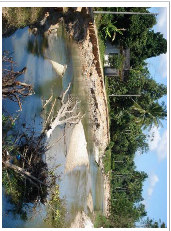
ภาพประกอบ 4-1 สภาพความเสียหายจากการขุดลอกคลอง
