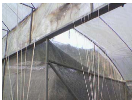
ภาพที่ 4 สภาพภายในโรงเรือนและหลังคาชำรุดฉีกขาด
