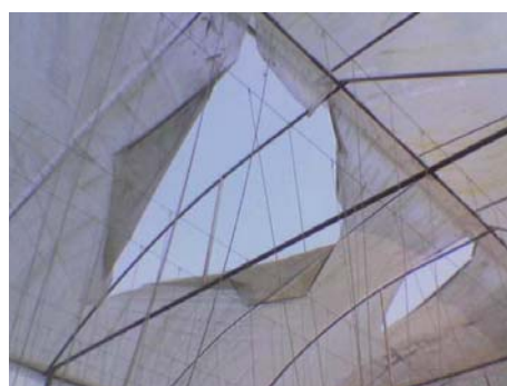
ภาพที่ 4 สภาพภายในโรงเรือนและหลังคาชำรุดฉีกขาด
