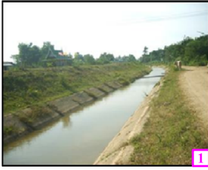
คลองส่งน้ำสาย 1ข-ส1
