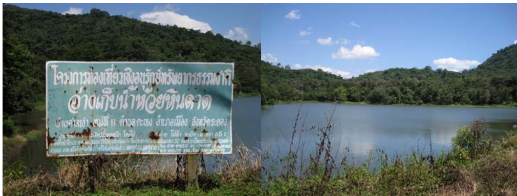
รูปที่ 2-11 อ่างเก็บน้ำห้วยหินดาด หมู่ที่ 11 ต. ตะพง
