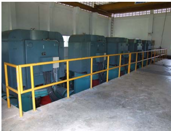
ภาพที่ 5.1 เครื่องสูบน้ำและคลองส่งน้ำของสถานีสูบน้ำด้วยไฟฟ้า บ้านเวินชัย (P6/1)
