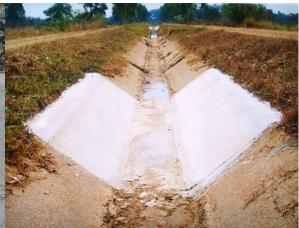
ณ. คลองน้ำได้รับการซ่อมแซมก่อนฤดูปลูก
