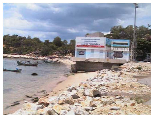
ภาพที่ 7 การกัดเซาะที่หาดชลาทัศน์ เนื่องจากโรงสูบน้ำเสียที่เป็นสิ่งแปลกปลอมที่ล่วงล้ำขอบเขตที่ได้รับอิทธิพลจากชายฝั่งของหาดชลาทัศน์
