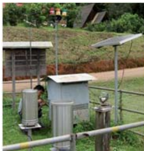
รูปที่ 3 ระบบเตือนภัยแบบอัตโนมัติผ่านระบบเครือข่ายโทรศัพท์
