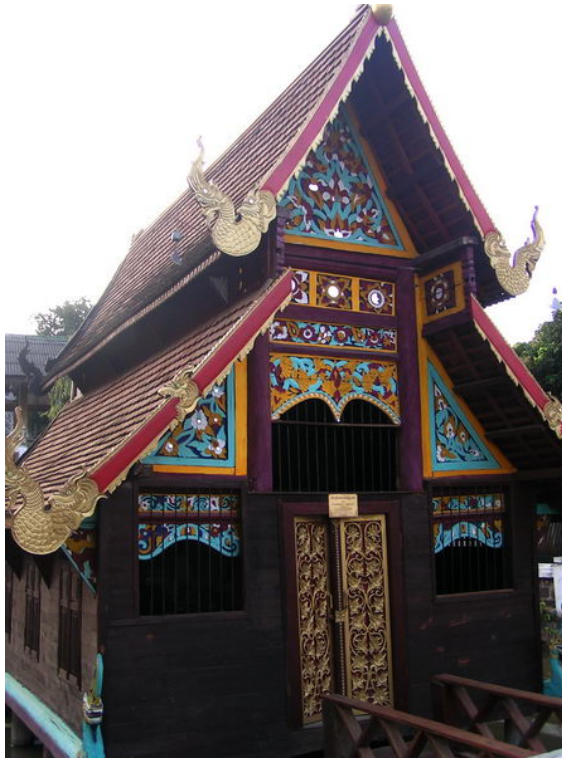
ภาพที่ 4.243 หน้าบ้านอุโบสถวัดพุทธเด่นเป็นไม้แกะสลักเขียนสีประดับกระจก
