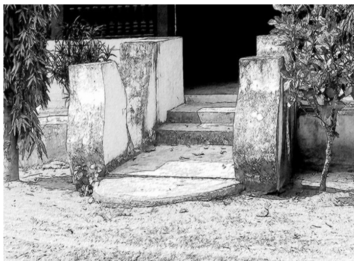
ภาพที่ 4.219 ราวบันไดลักษณะเฉพาะของวัดยางหลวง
