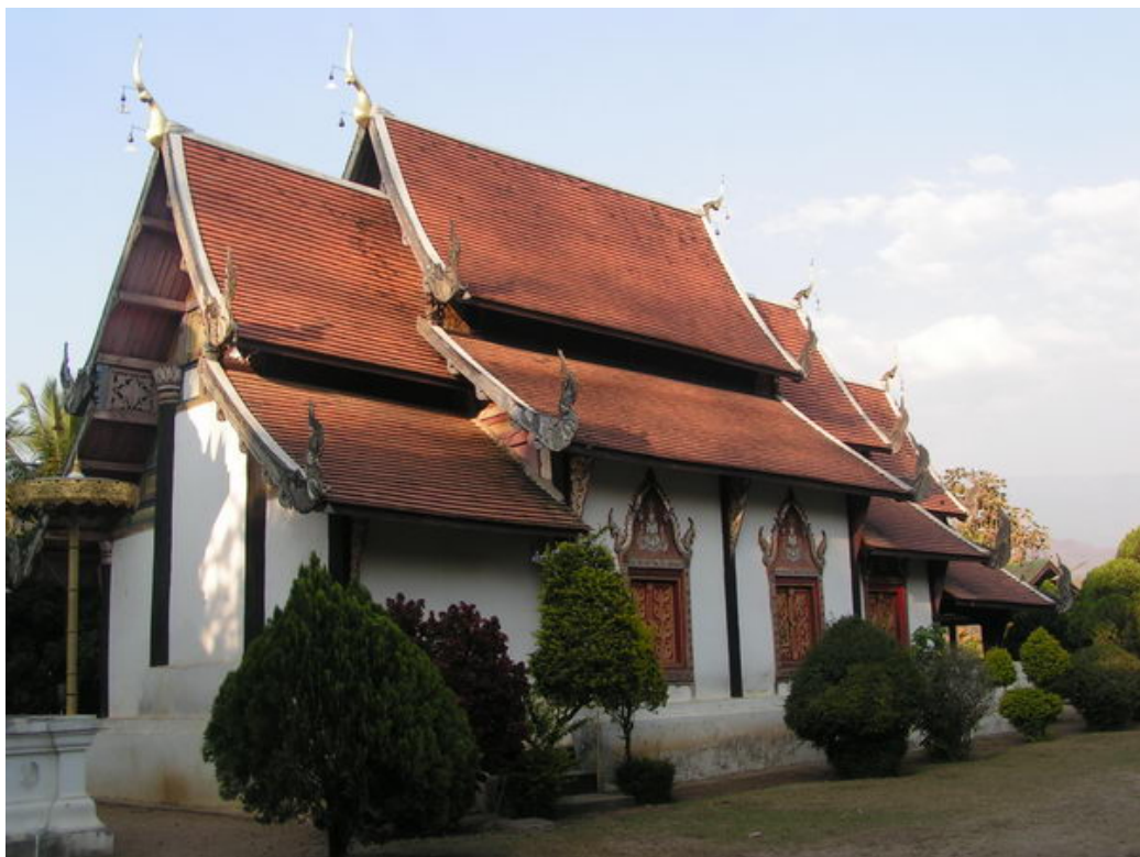
ภาพที่ 4.211 วิหารวัดพุทธเข็น ด้านหลังไม่มีระเบียงมุข ทำให้มีลักษณะแบบไม่สมมาตรหน้าหลัง
