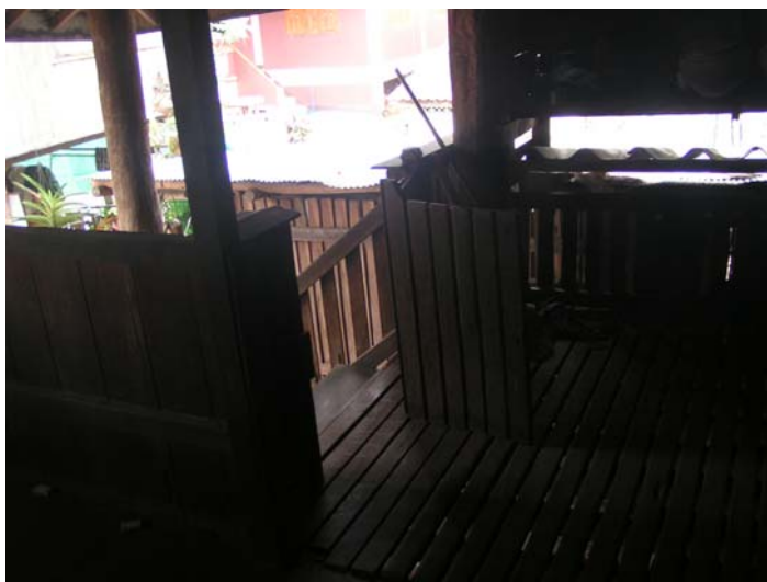
ภาพที่ 4.137 แสดงรูปพื้นไม้ดีเว้นช่องระบาย หลังที่ 17 ชุมชนพรวัวหนุ่ม
