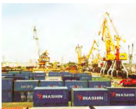
รูปที่ 4.10 Le Thanh Tong Container Yard
