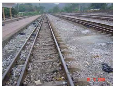
รูปที่ 13 รางรถไฟมี 3 เส้น สามารถรองรับรถไฟได้ 2 ขนาดราง
