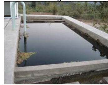
บ่อหลังตกตะกอน
