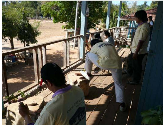
รูปที่ 3 การซ่อมแซมไม้ระแนงกันตก
