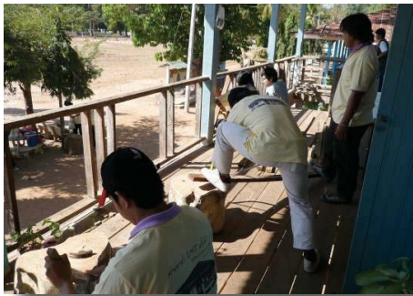
รูปที่ 3 การซ่อมแซมไม้ระแนงกันตก
