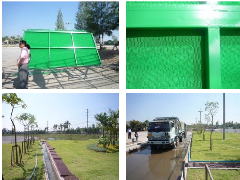
รูปที่ 4-4 การป้องกันการฟุ้งกระจาย ณ พื้นที่จุดเทกองของบริษัท บ้านปู จำกัด (มหาชน)
