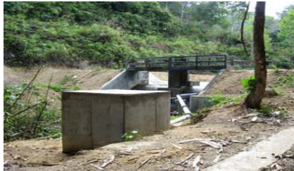
ภาพที่ 4.3 แสดงรูปโรงกรองน้ำและอาคารลดพลังงาน
