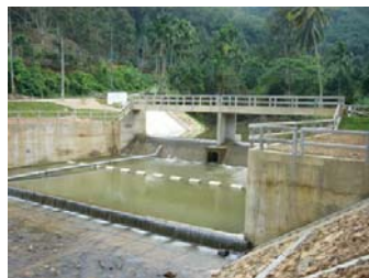
ภาพที่ 4.2 แสดงรูปฝายทดน้ำประปาภูเขาที่ก่อสร้างโดยกรมชลประทาน
