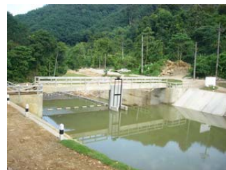
ภาพที่ 4.2 แสดงรูปฝายทดน้ำประปาภูเขาที่ก่อสร้างโดยกรมชลประทาน
