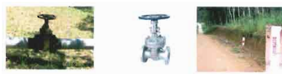
ภาพที่ 4.6 แสดงรูปประตุน้ำและหลักแนวท่อส่งน้ำ
