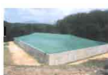
ภาพที่ 4.7 แสดงรูปถังเก็บ- ถังกรองน้ำขนาด 50 ลูกบาศก์เมตร และถังเก็บน้ำ 1,600 ลูกบาศก์เมตร
