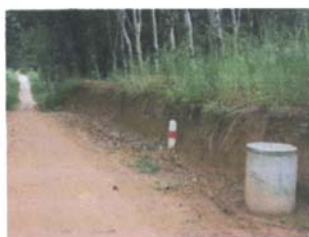
ภาพที่ 4.4 แสดงรูปลิ้นระบายอากาศ (แอร์วาล์ว) และประตูละบายตะกอน (โบลออฟ)
