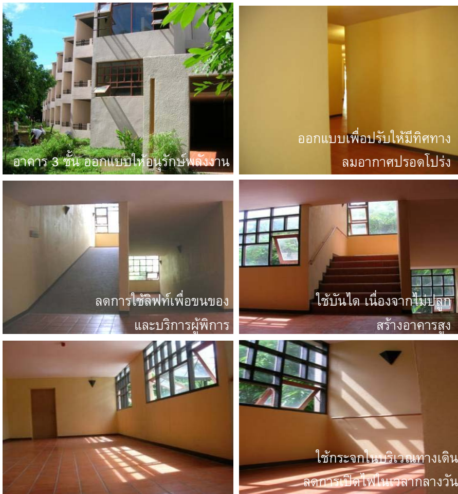
รูปที่ 4.8 อาคารที่พัก แสดงถึงการออกแบบที่อนุรักษ์พลังงาน
