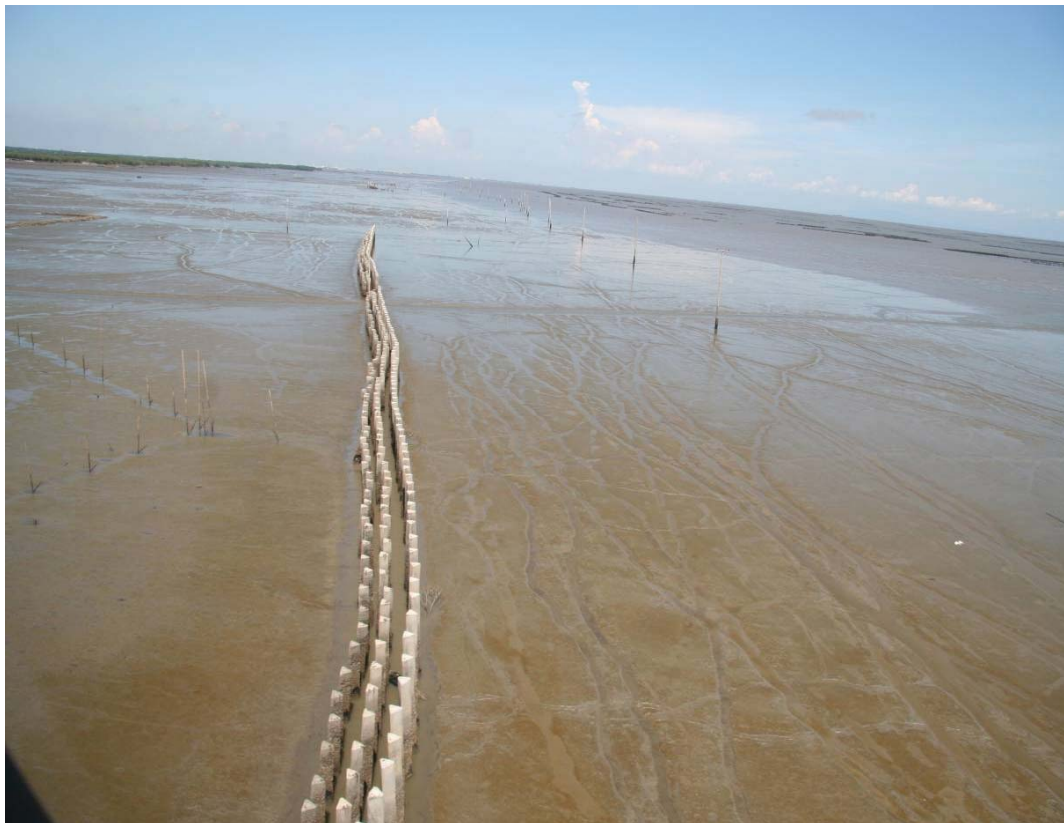
รูปที่ 5.1 แสดงการกัดเซาะระดับพื้นท้องน้ำบริเวณที่มีการติดตั้งโครงสร้างเสาสามเหลี่ยม “เขื่อนสลายกำลังคลื่น” จากคลื่นม้วนตัวปะทะโครงสร้าง (Scouring)
