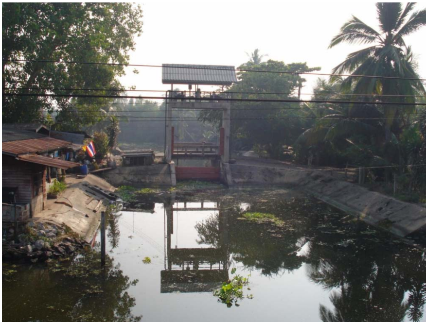
ภาพที่ 11 การก่อสร้างประตูระบายน้ำชลประทานระหว่างน้ำจืดและน้ำเค็ม
