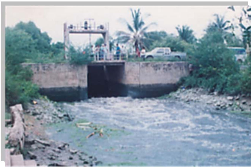
ภาพที่ 22 การก่อสร้างประตูระบายน้ำชลประทานกันระหว่างน้ำจืดและน้ำเค็ม
