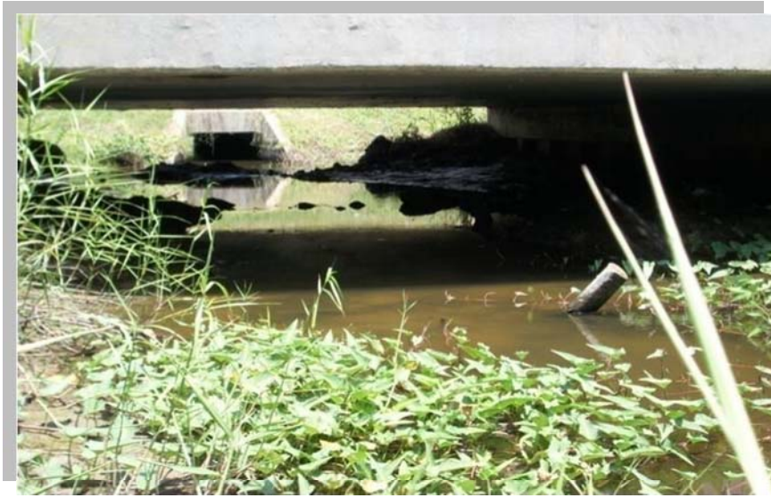
ภาพที่ 23 ตะกอนดินใต้สะพานและท่อลอด
