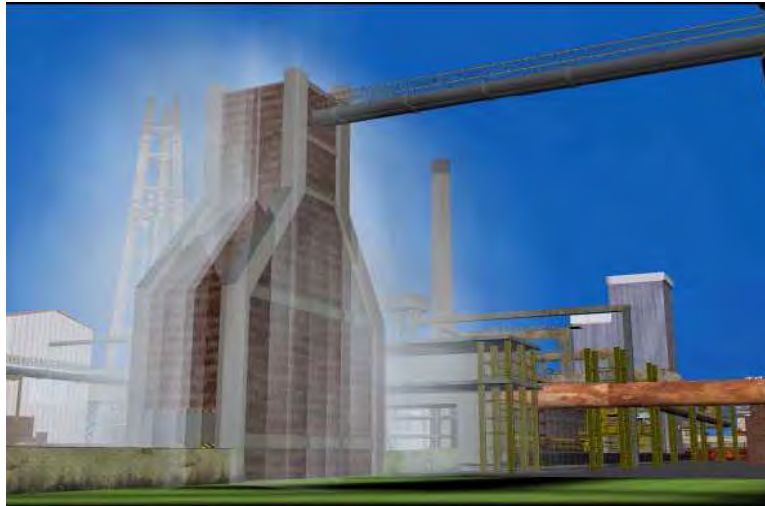
รูปที่ 2-10 ภาพสถานีทำความเย็น (Quenching station) ที่มีการพ่นละอองน้ำ ที่มีกำลังสูง [26]
