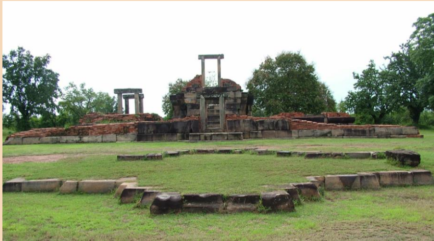
ปราสาทโนนกู่ เทวาลัยแบบเขมรที่สูงเนิน
