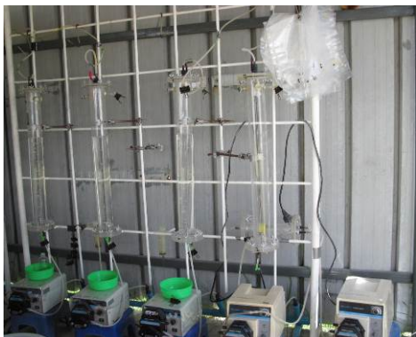
ก. ระบบดูดซึมทางเคมี
