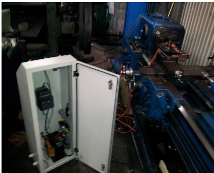
รูปที่ 44 ติดตั้งชุดอุปกรณ์อินเวอร์เตอร์ หม้อแปลงและตัวจับยึดใบมีดเข้าด้วยกัน
