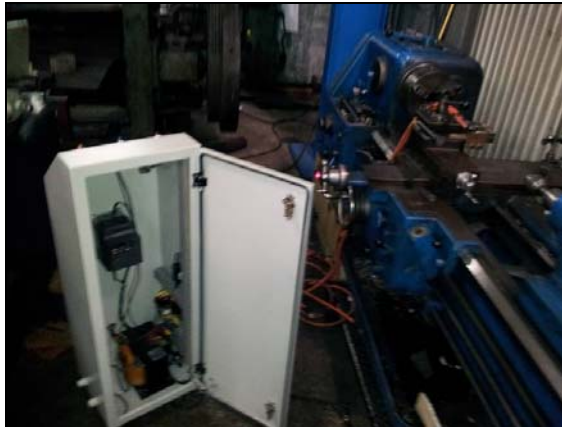
รูปที่ 10 ติดตั้งชุดอุปกรณ์อินเวอร์เตอร์ หม้อแปลงและ ตัวจับยึดไบมีดเข้าด้วยกัน
