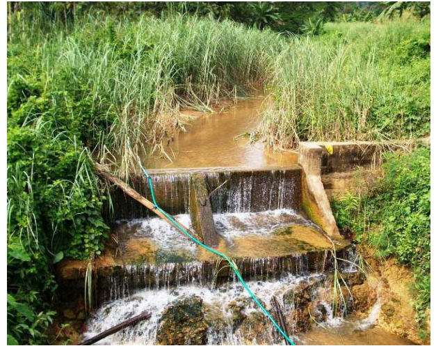
ปัญหาตะกอนดินทับถมในแหล่งน้ำฝายดินในช่วงปลายฤดูฝน บริเวณฝายน้ำล้น บ้านด้นจั่ว หมู่ 9 (บันทึกภาพ 4 พฤศจิกายน 2552)
