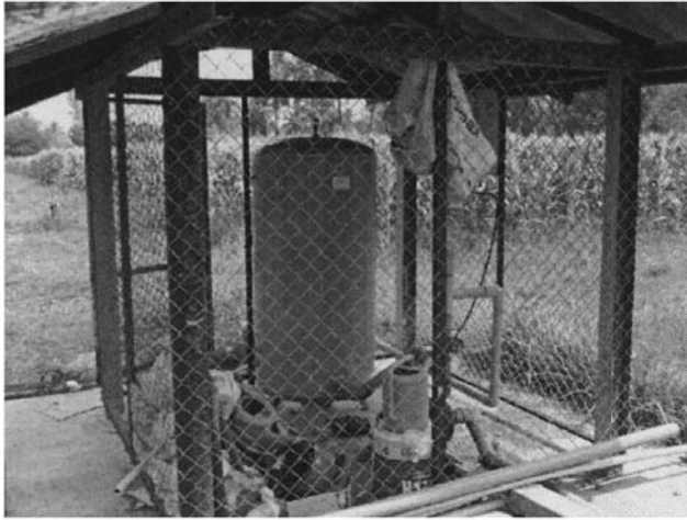
ปั้มน้ำและถังแรงดันระบบน้ำหยด
