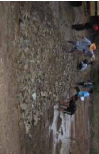
ภาพที่ 4-33 การนำหินมาทับเป็นแนว เพื่อป้องกันการพังทลายการกัดเซาะของน้ำ
