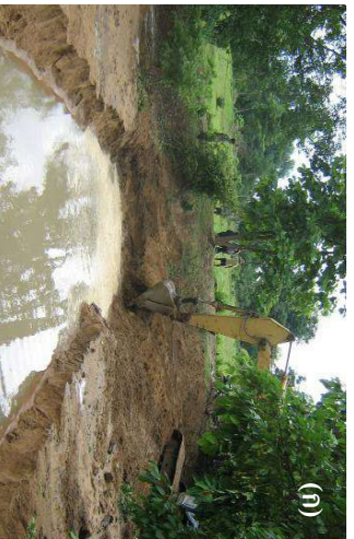
ภาพที่ 4-31 การขุดลอกคลองเพื่อจัดทำฝายแก้มดินเหนียว ใช้เครื่องจักรและแรงงาน
