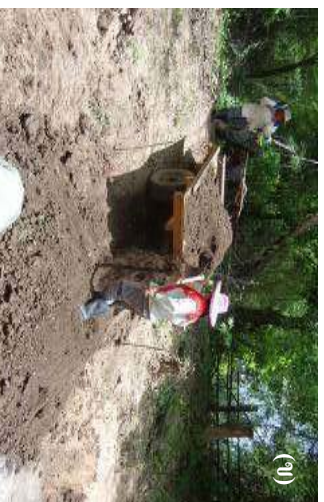
ภาพที่ 4-31 การขุดลอกคลองเพื่อจัดทำฝายแก้มดินเหนียว ใช้เครื่องจักรและแรงงาน
