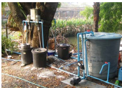
ภาพที่ 20 แสดงระบบการให้น้ำในการทดลองปลูกพริกในวัสดุปลูก
