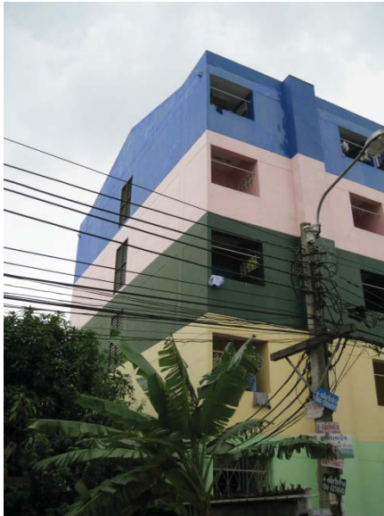
รูปที่ 5.37 หอพักที่ทำการตรวจวัด
