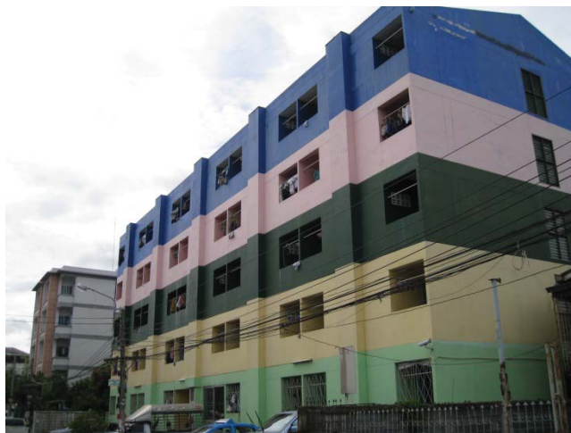
รูปที่ 5.38 หอพักที่ทำการตรวจวัด
