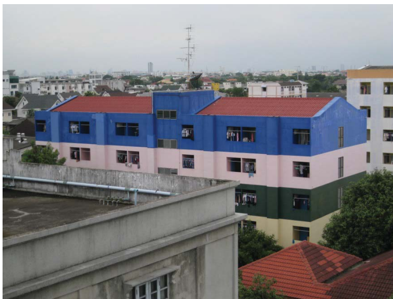
รูปที่ 5.39 หอพักที่ทำการตรวจวัด
