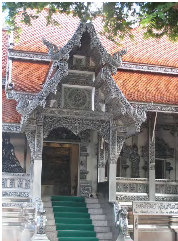
ทางเข้าหอศิลป์สุทนต์ สร้างเป็นแบบศิลปะล้านนา โดยใช้โครงสร้างแบบมั่วต่างใหม่
