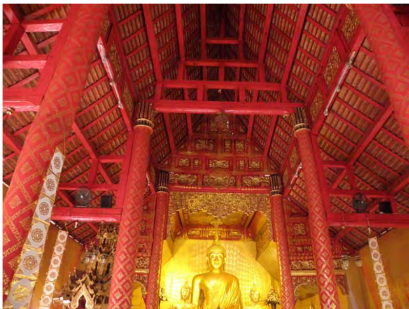
โครงสร้างเครื่องบนหลังคาแบบผ้าต่างใหม่ภายในวิหารวัดศรีสุพรรณ
