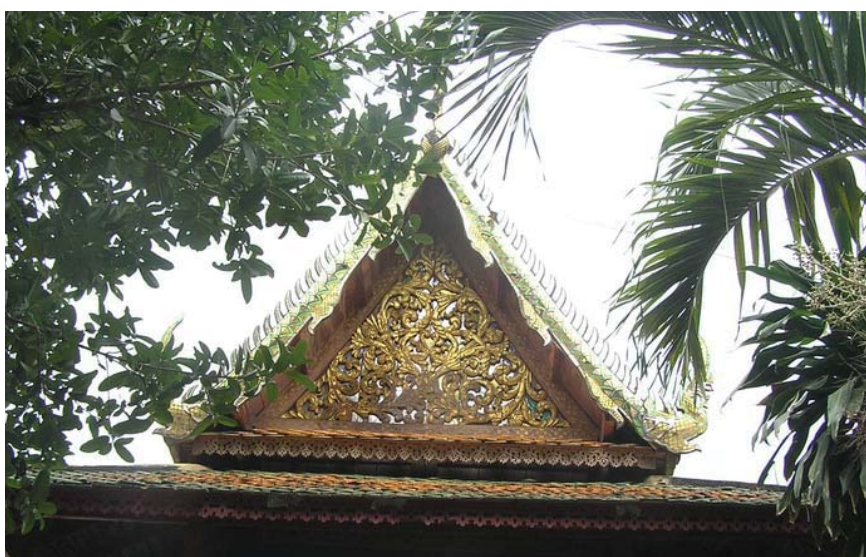
หน้าบันหอไตรวัดเสนาหิน เป็นลายแกะไม้ก้านขดแกะสลักปิดทองประดับกระจก
