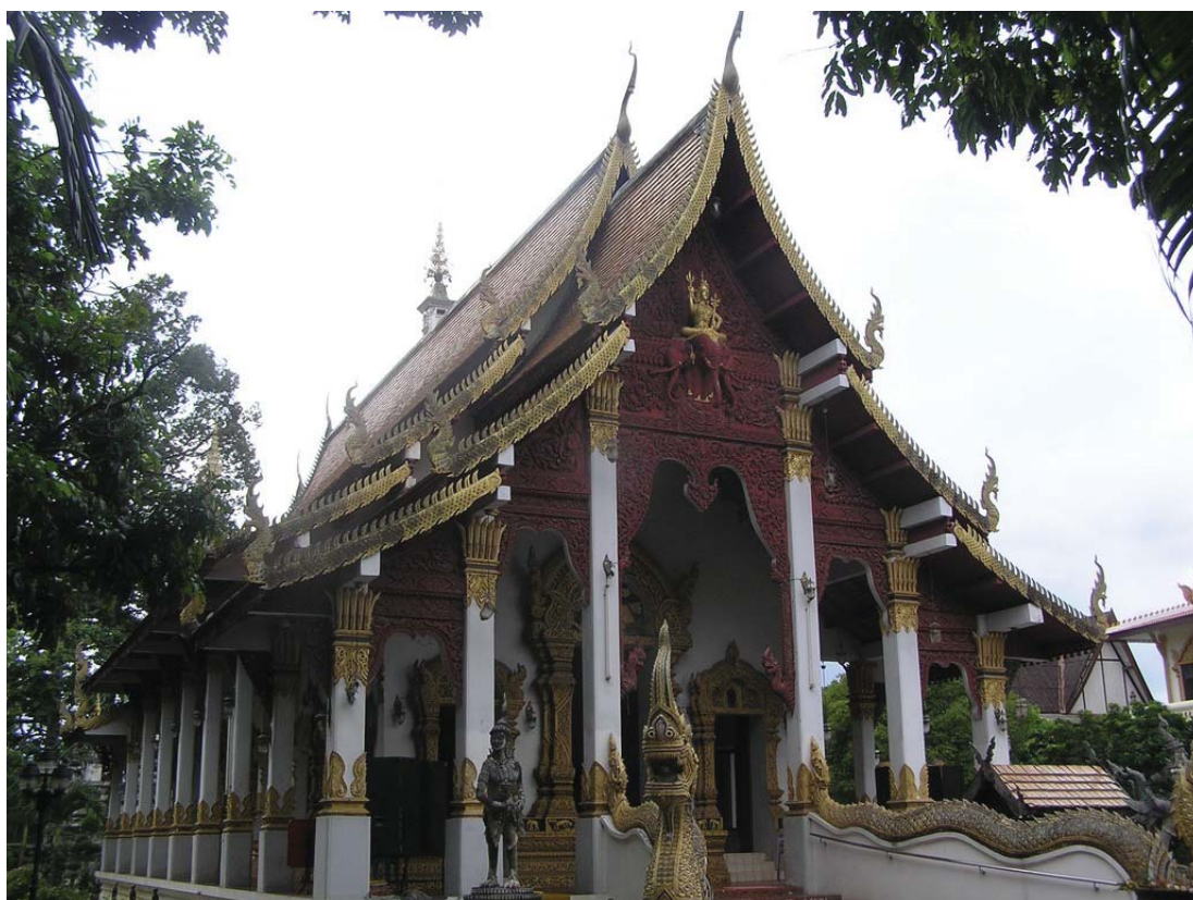
วิหารวัดช้างค้ำ ตัวอาคารก่ออิฐถือปูน หน้าบันเทคนิคแกะสลักไม้ มีบันไดนาคทางขึ้นด้านหน้า
