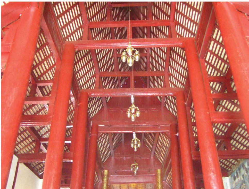
โครงสร้างเครื่องไม้วิหารวัดเสนาหิน เป็นโครงสร้างที่ปราศจากฝ้าเพดาน
