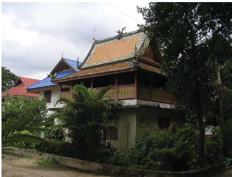
หอไตรวัดเสนาหิน เป็นอาคารสองชั้น ชั้นล่างก่ออิฐถือปูนชั้นบนเป็นเครื่องไม้
