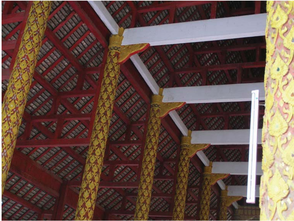
โครงสร้างหลักภายในอาคารเป็นโครงสร้างจากปูน โดยส่วนซื่อและคานรองรับขนาดเล็กยังคงใช้ไม้
