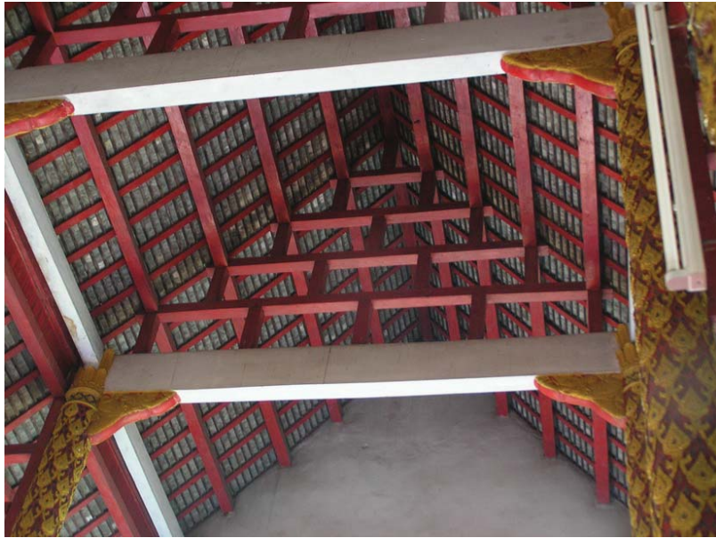
โครงสร้างเหนือคานปูน ยังคงใช้ชุดเสา คานที่ทำจากไม้ ส่วนแผงหน้าบันมองจากด้านในเห็นได้ว่าเป็นแผงปูน
