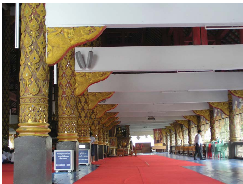
เสา และคานในวิหาร เป็นเสาและคานที่ทำจากปูนมิใช่เสา และคานที่ทำจากไม้
