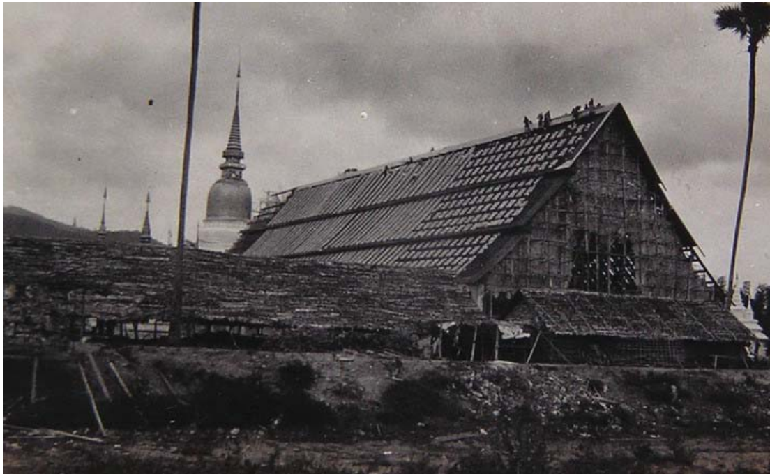
วิหารวัดสวนดอกในขณะที่กำลังก่อสร้าง (ภาพ; หอจดหมายเหตุแห่งชาติ)
