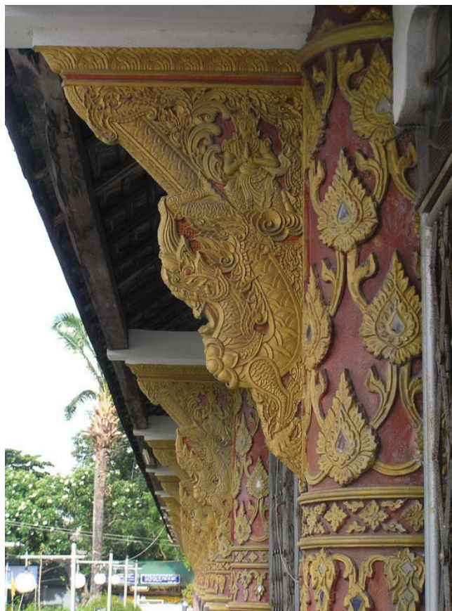
กันทวย หรือ นาคตันถ้ายันเสาววิหาร สร้างด้วยเทคนิคการหล่อปูน
