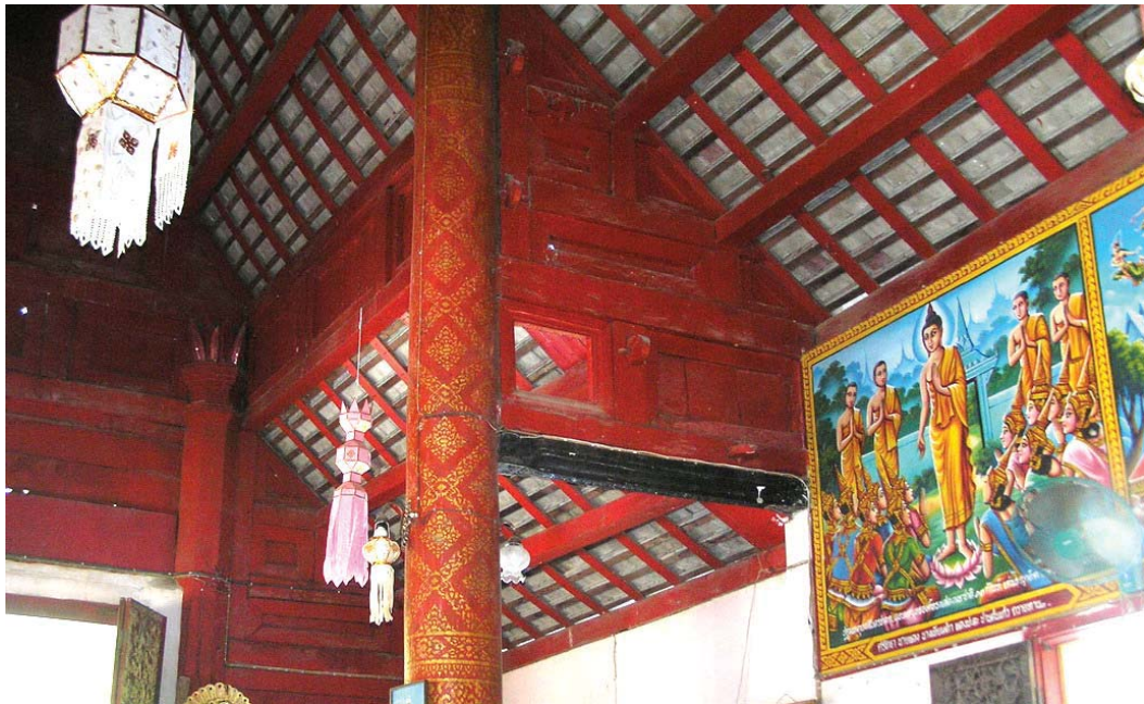
โครงสร้างไม้ในหลังคาวิหารเป็นโครงสร้างแบบมั่วต่างใหม่
