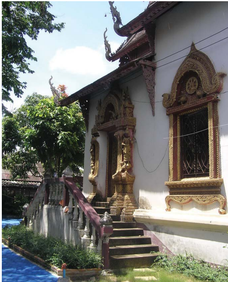
บันไดด้านข้างวิหาร เห็นโครงสร้างอาคารผนังก่ออิฐถือปูน เจาะช่องหน้าต่าง
