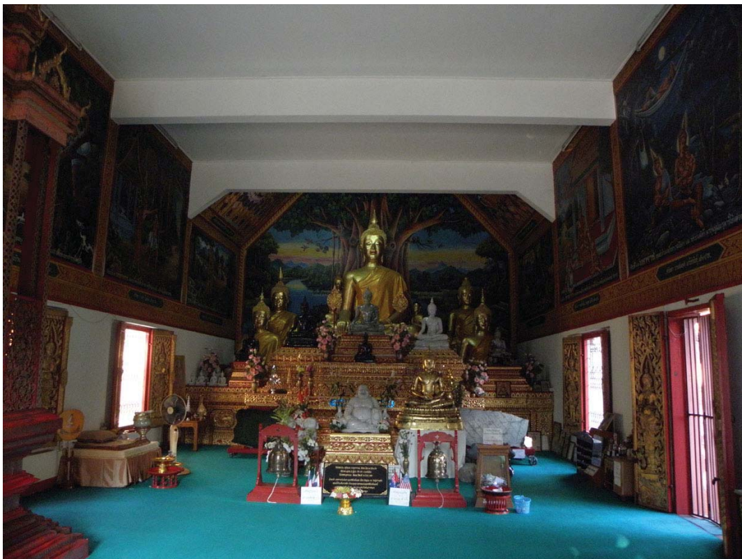
ภายในวิหาร แลเห็นคานคอนกรีตในด้านบนเพดาน
