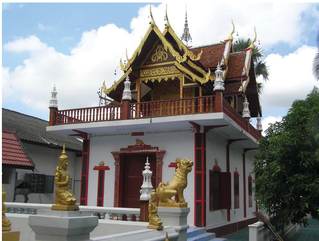
หอไตรวัดศรีปิงเมืองเป็นอาคาร 2 ชั้น ชั้นล่างก่ออิฐถือปูน ชั้นบนสร้างด้วยไม้
