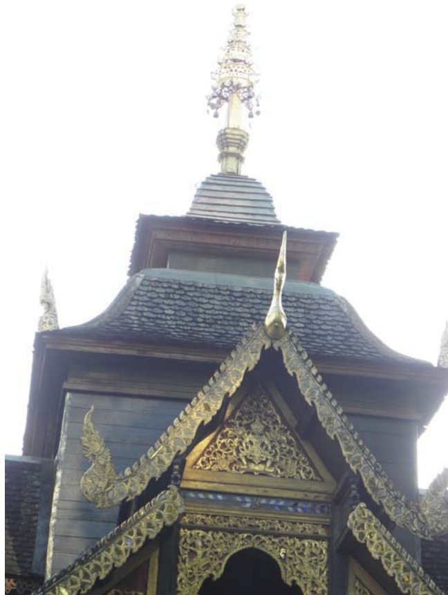
ส่วนหลังคาหอไตรวัดอุทรายคำ มีหลังคาส่วนบนในผังสี่เหลี่ยมที่แอ่นโค้งมาบรรจบกัน
