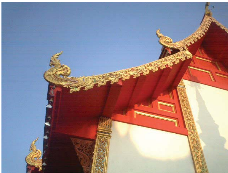
ด้านหลังวิหาร แลเห็นการใช้โครงสร้างเครื่องบนแบบไม้ต่างใหม่ ที่มีชื่อ คาน รองรับชุดหลังคา ส่วนปั้นลม และหางหงส์ เป็นรูปมกรคายานาค
