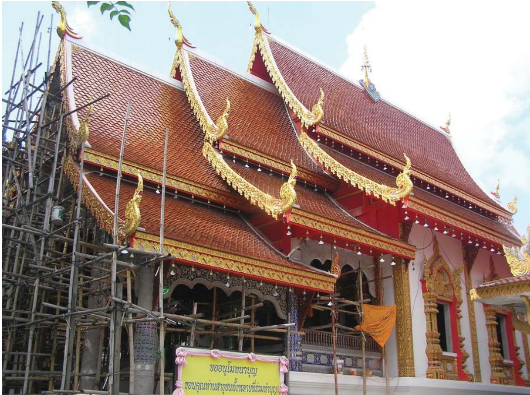
วิหารวัดศรีปึงเมือง ในสภาพที่กำลังบูรณะปฏิสังขรณ์ขึ้นใหม่ เป็นอาคารก่อผนังทึบทั้งสี่ด้าน มีมุขในด้านหน้าอาคารลดชั้นจำนวน 2 ชั้น
