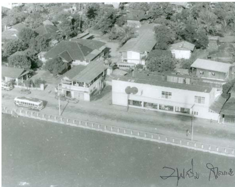
ถนนเลียบแม่น้ำปิงสายเชียงใหม่ - ลำพูน ผ่านบริเวณโรงแรมศรีประกาศด้านเหนือของชุมชนท่าสะต๋อย (ที่มา : บุญเสริม สาสตราภักย์ ถ่ายภาพพ.ศ.2512)
