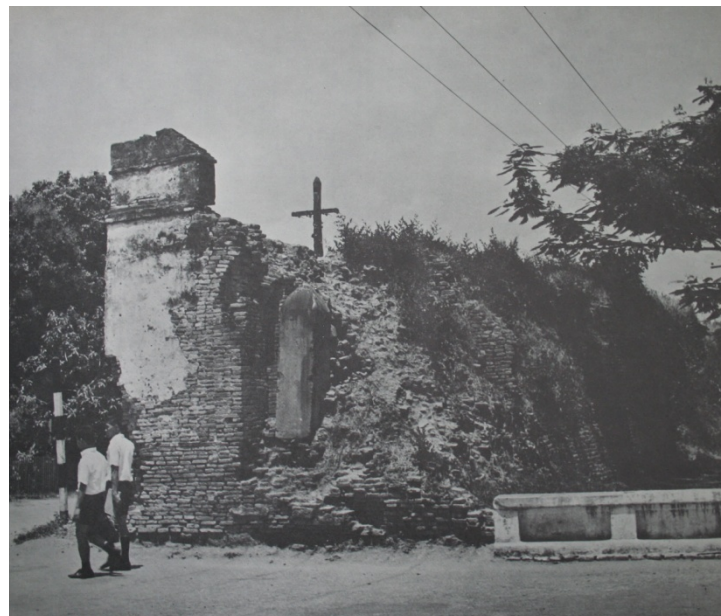
ประตูช้างม้อย(ใหม่)ที่สร้างขึ้นเมื่อมีการตัดถนนช้างม้อยสายใหม่
